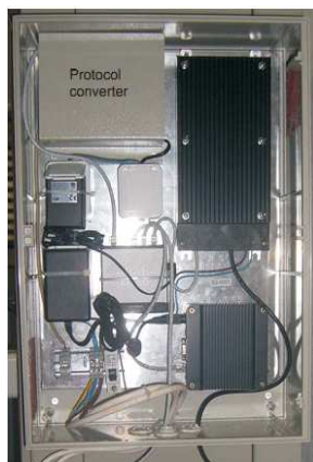
SLIKA 3 - BPL oprema za SN mrežu
