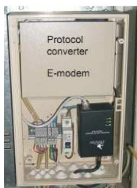
SLIKA 2 - BPL oprema za NN mrežu
